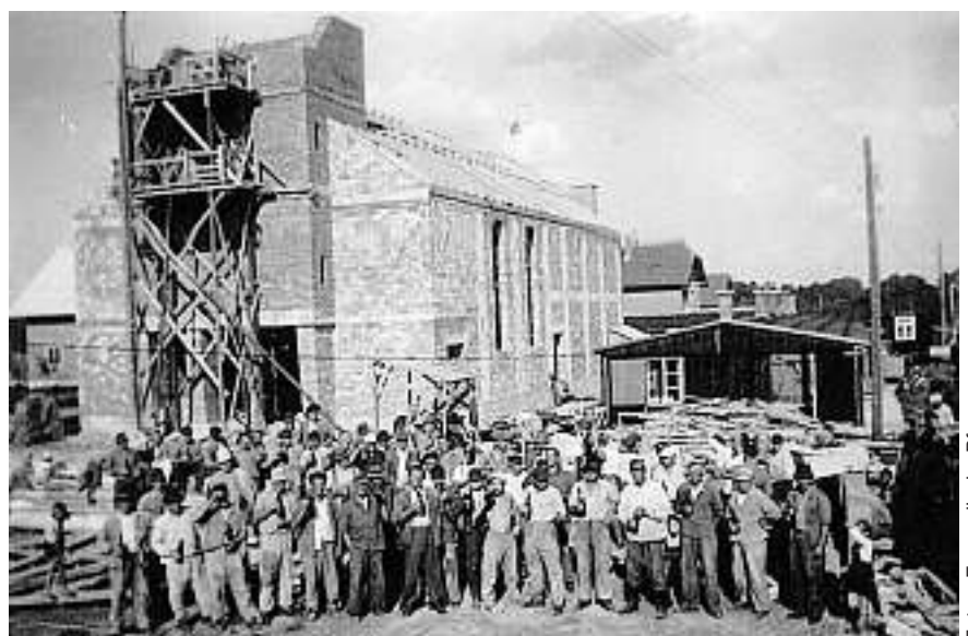
Bilder aus 1958 vom Bau der Gnadenkirche.
