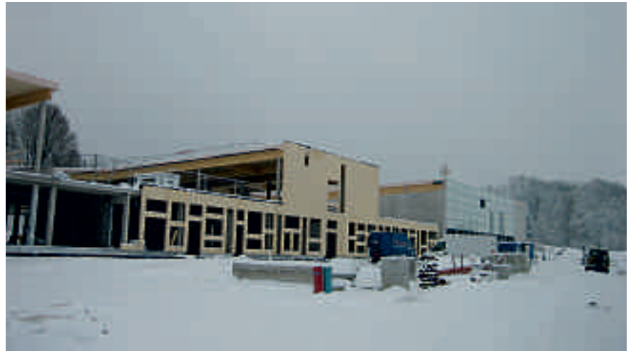
Anbringung der Fassaden-Unterkonstruktion im Hauptschulbereich
